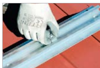
- Nutenstein montieren...
